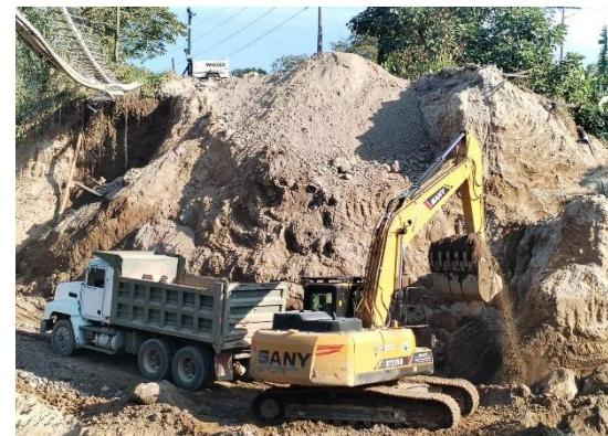
En el kilómetro 189 de la ruta CA-2 Occidente, en jurisdicción de San Felipe, Retalhuleu, avanzan los trabajos de excavación para resolver el colapso de una bóveda que ha afectado la circulación vehicular en esta importante vía.
