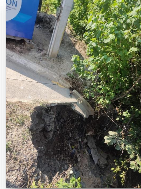
Derrumbe en la parte posterior de los contenedores
