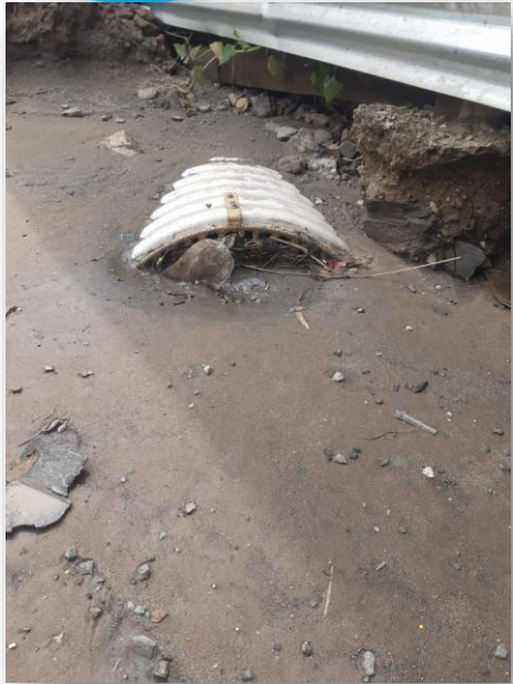
Sistema de drenaje transversal colapsado
