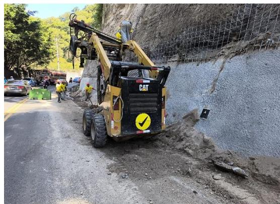
El primer muro, de 40 metros de altura y 35 metros de largo, lleva un avance del 80%, actualmente se lleva a cabo la fundición del muro con concreto de alta resistencia.
