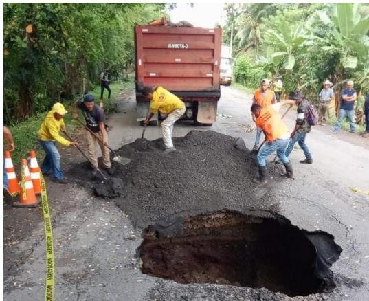
El problema se originó por el azolvamiento de uno de los cabezales de la tubería y los daños propios de su antigüedad. El deterioro de la estructura, fabricada en metal corrugado, con una longitud aproximada de 25 metros, diámetro de 30 a 36 pulgadas y profundidad cercana a los 10 metros, generó fisuras que permitieron el paso de humedad al relleno existente entre la tubería y el pavimento, provocando erosión, socavamiento y, finalmente, el colapso parcial de la vía.
